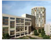
Henan International Exchange Centre 河南师大附中施工中
