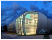
Untron Factory Extension in Suzhou 优利康苏州扩建项目
