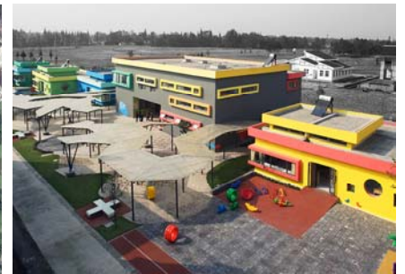
September 2010: The kindergarten after its opening in 2010. 2010年9月：开学后的幼儿园。
